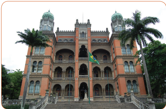
FOTO 1 – PAVILHÃO MOURISCO, PRÉDIO CENTRAL DA FUNDAÇÃO OSWALDO CRUZ – RIO DE JANEIRO
